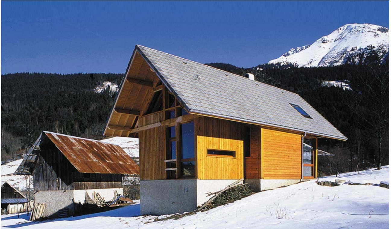
Fig. 31 : maison CR à Laval (Isère) par Macary Bensch architecture, 1997. Source : https://www.macary-bensch-architecture.com
