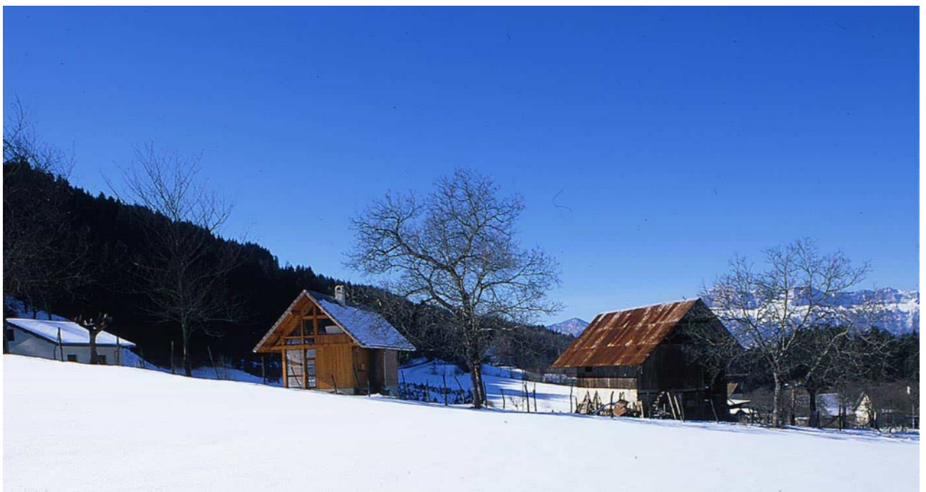
Fig. 32 : maison CR à Laval (Isère) par Macary Bensch architecture, 1997. Source : https://www.macary-bensch-architecture.com
