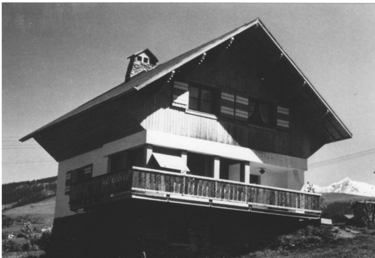
Fig. 30 : chalet dit "Le Miage" à Megève (Haute-Savoie) par Henry Jacques LE MEME, construit en 1939, photographie de Marcel DUPUIS en 1939. Source : Inventaire général en Auvergne-Rhône-Alpes, mai 2023, https://patrimoine.auvergnhhonealpes.fr
